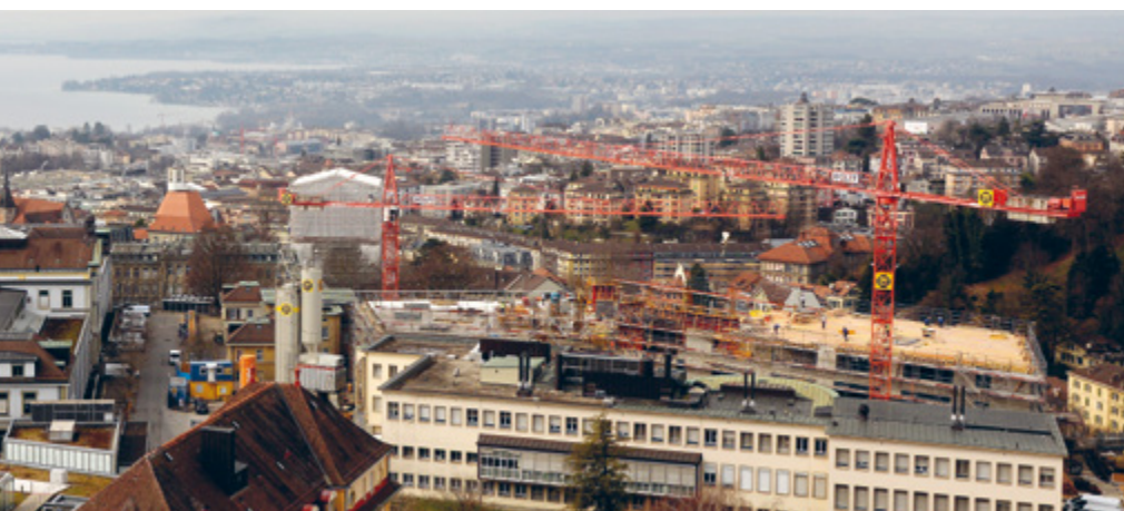
Ci-contre Chantier AGORA – Vue Sud
