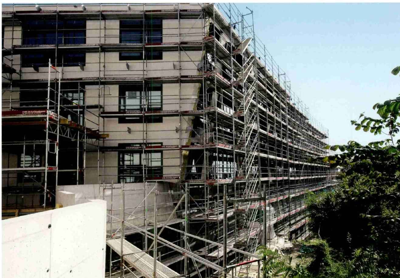
L'enveloppe est un béton ordinaire. Une isolation crépie sera posée, avec un double encollage pour contrearrer les dilatations thermiques. Le crépi de couleur gris-vert foncé fera ressortir la couleur blanc brillant de l'habillage métallique.
