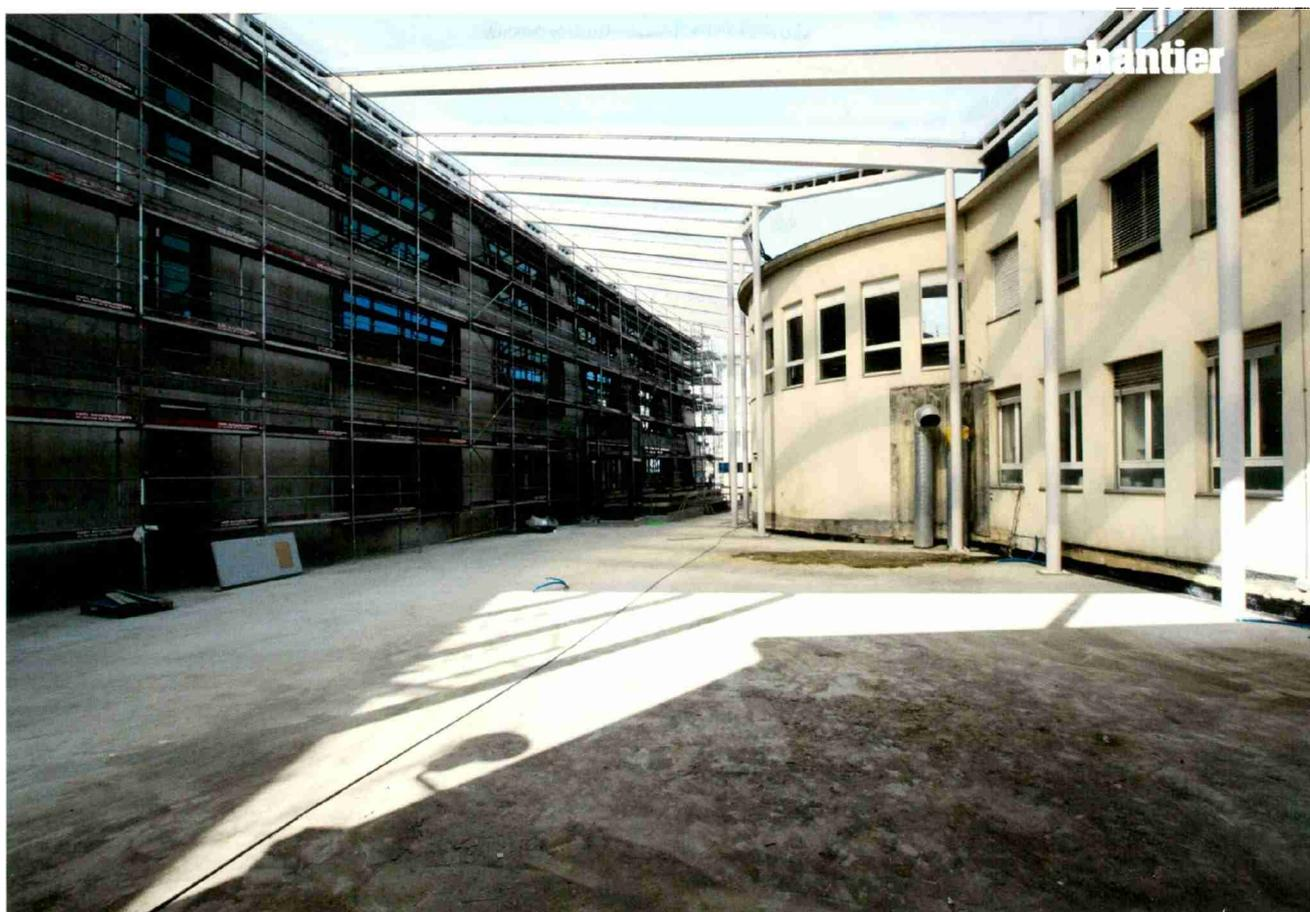
Structure métallique du futur atrium. A droite, le bâtiment dédié à la pathologie dont le crépi sera remplacé par une finition minérale plus lisse, et en face, la façade d'Agora, qui sera couverte de bois. En toiture, un ETFE avec une sérigraphie pour filtrer le soleil.
